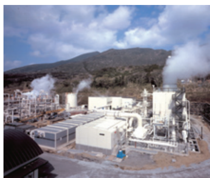
八丈島にある東京電力の地熱発電所 写真提供：東京電力
