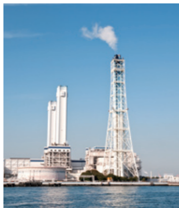
臨海地区に建設されること多い火力発電所
