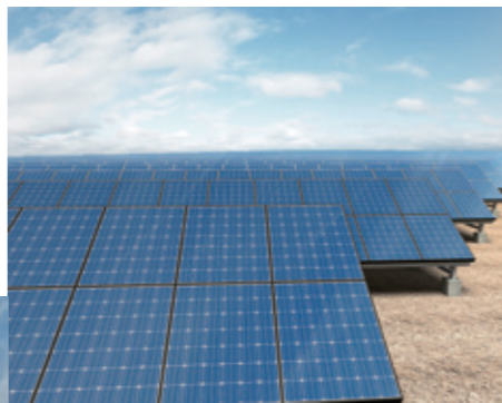
広大な面積のパネルを設置するメガソーラー
